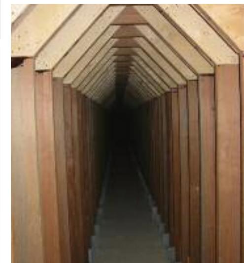
Die Luftkanäle werden mit einem Hartholzmantel versehen.
